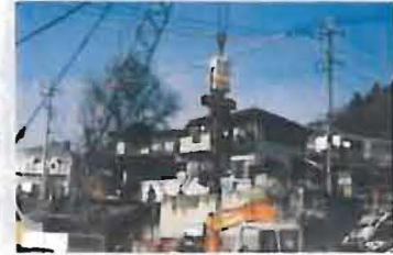
杭規格：φ500×15m 発注：東京都 工事名：道路改修工事及び補償代行工事
