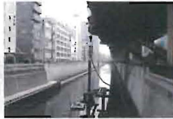
杭規格：H350×350 (L=17.5m) 発注：東京都 工事名：神田川整備工事
