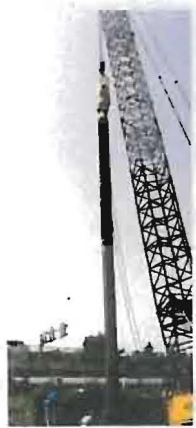
矢板規格：SP-IIIw型 (L=21m) 発注：神奈川県 工事名：相模川流域下水道左岸処理場土留工事
