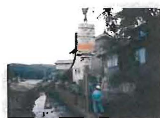
矢板規格：SP-II型 (L=8m) 発注：石川県 工事名：大谷川広域基幹河川改修工事
