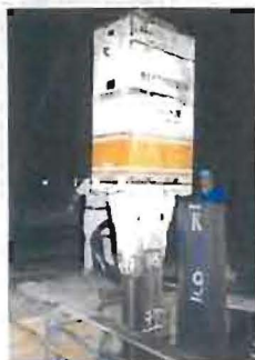
杭規格：H350×350 (L=38.0m) 発注：長野電鉄 工事名：松代駅構内雨水排水路新設工事
